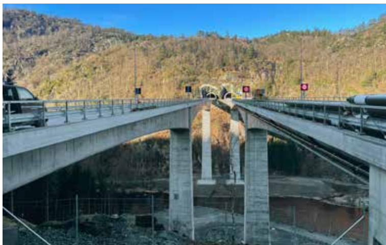
Nye E39 mellom Kristiansand og Mandal er ferdig. Om cirka 15 år er veien bygget til Stavanger. Foto: Nils Bernt Rinde/Nye Veier
