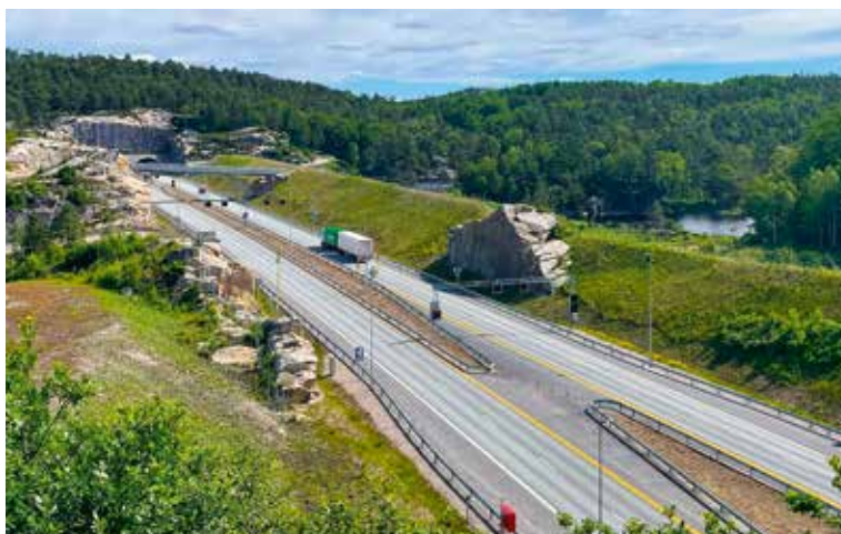
E39 Lyngdal øst - Lyngdal vest. Veien bygges fra sør og vestover mot Stavanger. Foto: Nils Bernt Rinde/Nye Veier
