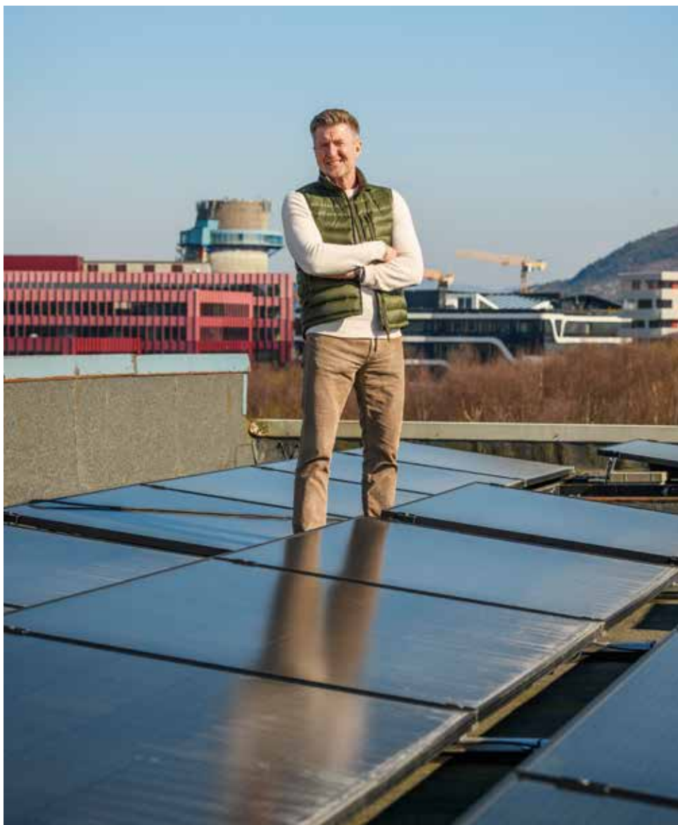
Styreleder Atle Sonesen blant solcellene på taket til RK Tekniske eget bygg på Hinna i Stavanger.
